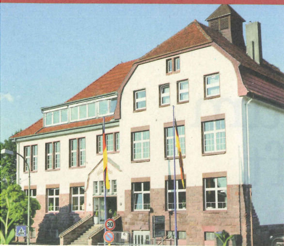
Der Firmensitz von Krämer IT Solutions – in der denkmalgeschützten Koßmannschule – hat eine bewegte 100-jährige Geschichte. Michael Krämer übernahm das Gebäude im Jahr 2005, sanierte es von Grund auf, bewahrte aber den ursprünglichen Charakter und viele historische Details des Hauses.
